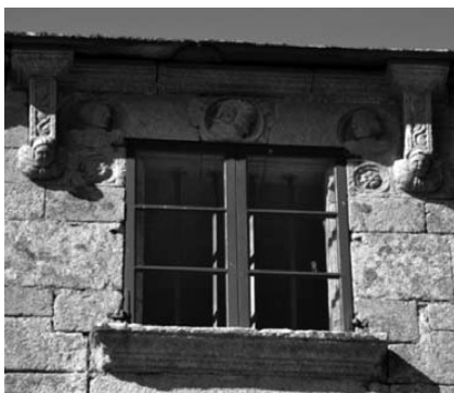
Primeiro andar, corpo central: ventá renacentista con peitoril.
