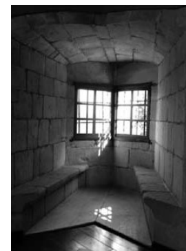
Planta primeira, salón principal: Ventá en ángulo con columna central esquinada (xeminada).
